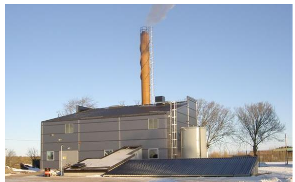
Morbylanga (Suecia). Calor 5 MW. Biomasa.
