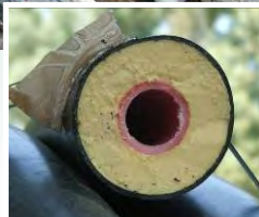
Derivación y detalle del tubo preaislado flexible utilizado en la red de calor. Estos tubos facilitan la instalación de la red y minimizan la apertura de zanjas y las pérdidas de calor.
