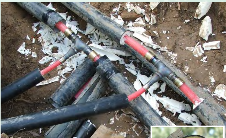
Derivación y detalle del tubo preaislado flexible utilizado en la red de calor. Estos tubos facilitan la instalación de la red y minimizan la apertura de zanjas y las pérdidas de calor.
