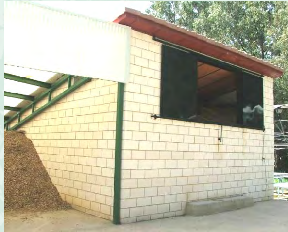
Arriba: Acopio de astilla y caseta de la caldera y silo, con ventana para el aporte de astilla. Abajo: Sistema de alimentación desde el silo a la caldera.
