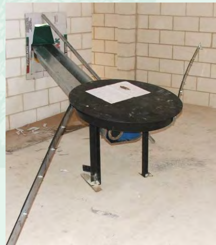
Arriba: Acopio de astilla y caseta de la caldera y silo, con ventana para el aporte de astilla. Abajo: Sistema de alimentación desde el silo a la caldera.
