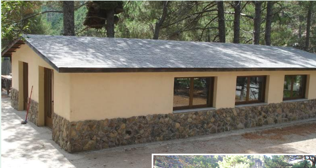
Cerramiento de comedor y detalle del interior
