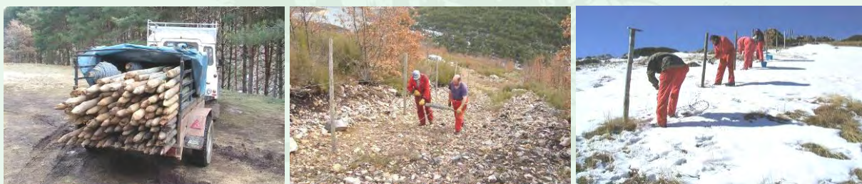
Reparación y colocación de cerramiento ganadero en la provincia de Palencia.
