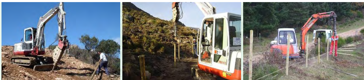
Mini retro de cadenas para la apertura mecanizada de hoyos y para el clavado de postes.
