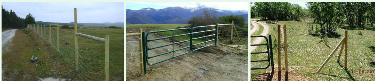
Cerramientos ejecutados por FORESA en Valgañón (La Rioja) y en Segovia.
