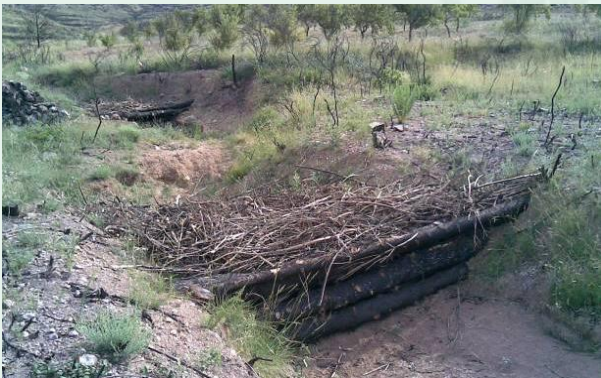
Albarrada en cárcava realizada con los restos del tratamiento selvícola, y dique de mampostería.
