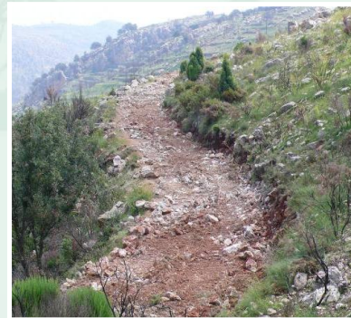
Mejora de pistas forestales. A la derecha, estado previo. Repasos, nuevos trazados, pasos de agua y muros de contención en seco.
