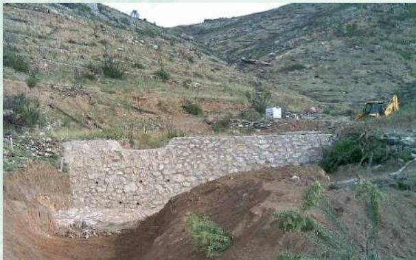
Albarrada en cárcava realizada con los restos del tratamiento selvícola, y dique de mampostería.
